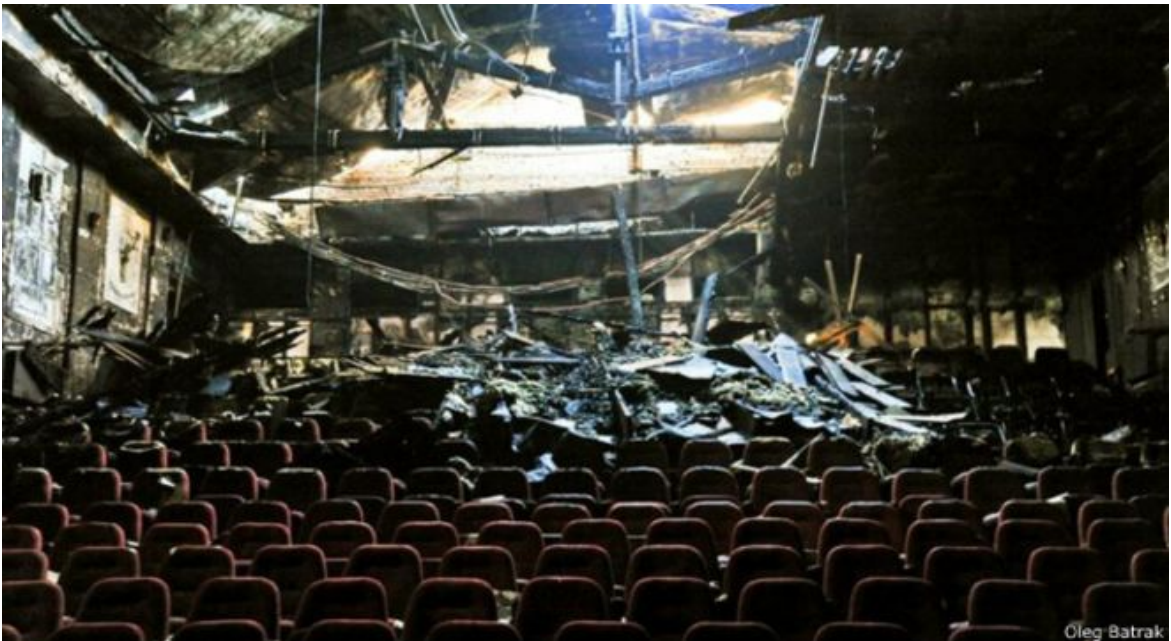
Зруйнований в результаті підпалу кінозал
